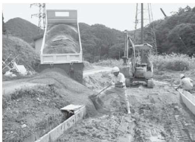
待避所設置工事①（H22.10）
