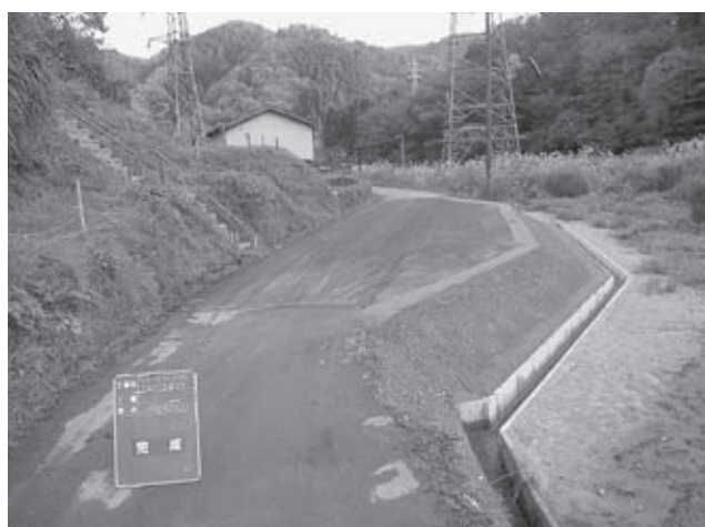
待避所設置工事②（H22.11）
